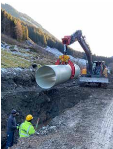
Die Verlegung der Druckrohrleitungen ist seit Dezember 2020 im vollen Gange und wird voraussichtlich im Frühjahr abgeschlossen sein.
