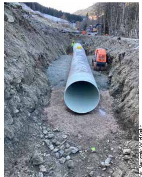
Die Verlegung der Druckrohrleitungen ist seit Dezember 2020 im vollen Gange und wird voraussichtlich im Frühjahr abgeschlossen sein.
