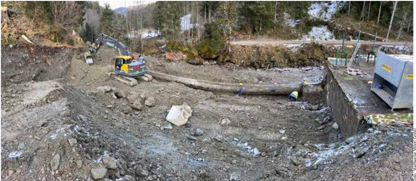
Die bestehende Wehranlage wurde bereits freigelegt, damit die Betonarbeiten für die neue Wasserfassung durchgeführt werden können.
