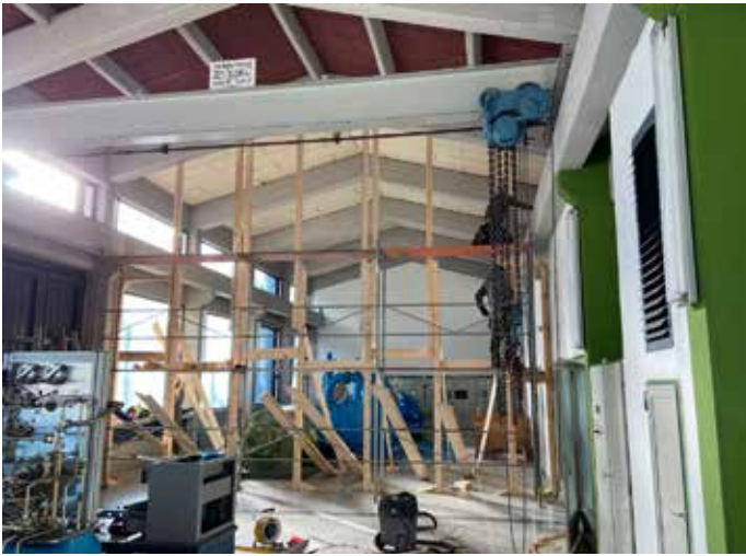
Diese Trennwand im bestehenden Krafthaus schützt die technischen Anlagen des E-Werkes Hopfgarten vor Lärm und Staub.
