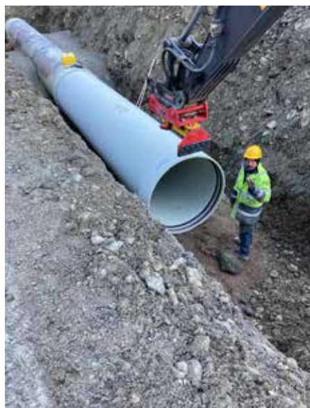
Die Verlegung der Druckrohrleitungen ist seit Dezember 2020 im vollen Gange und wird voraussichtlich im Frühjahr abgeschlossen sein.
